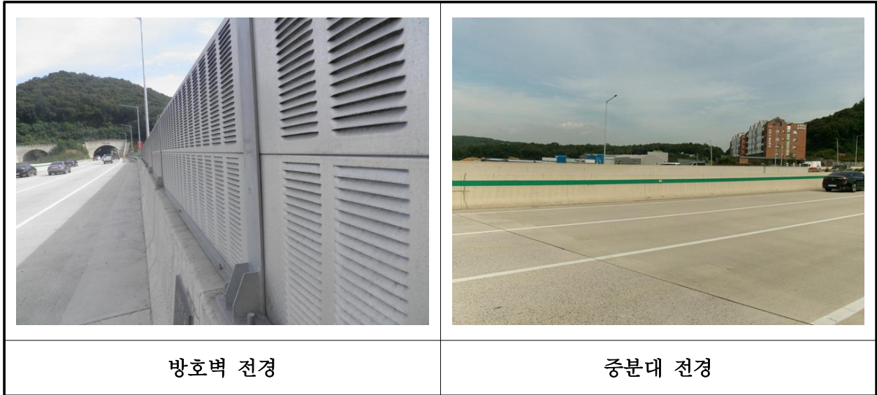
【사진 29.3.20】 방호벽 및 중앙분리대 전경
