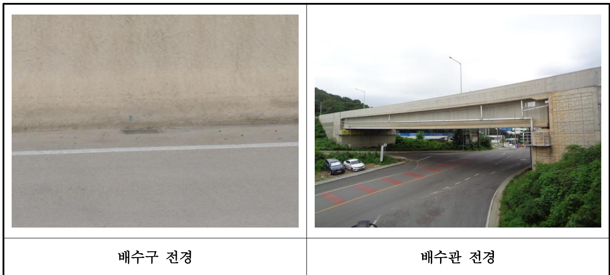
【사진 29.3.18】 배수시설 전경
