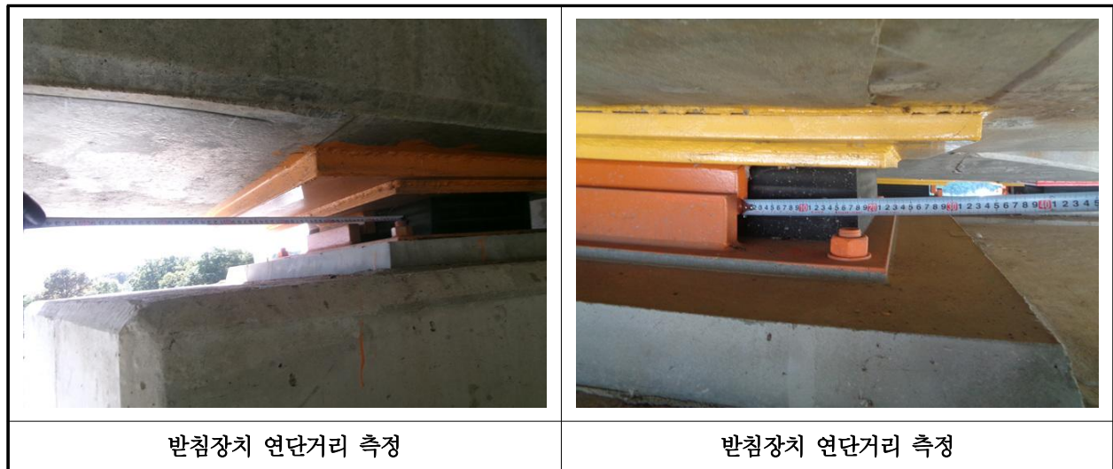
【사진 29.3.12】 교량받침장치 연단거리측정
