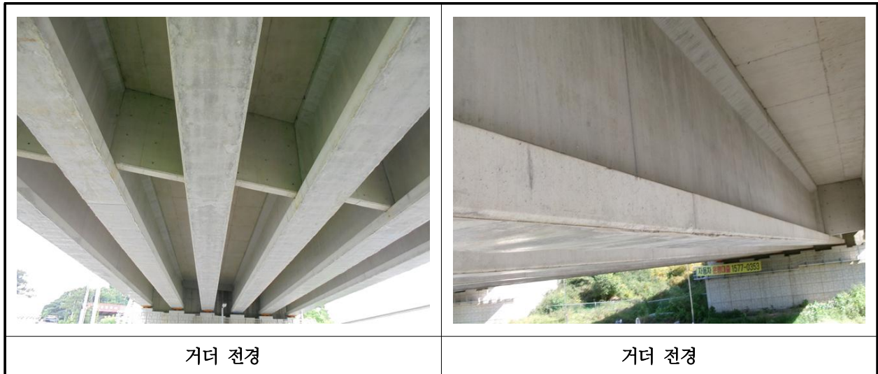
【사진 29.3.4】 거더 전경
