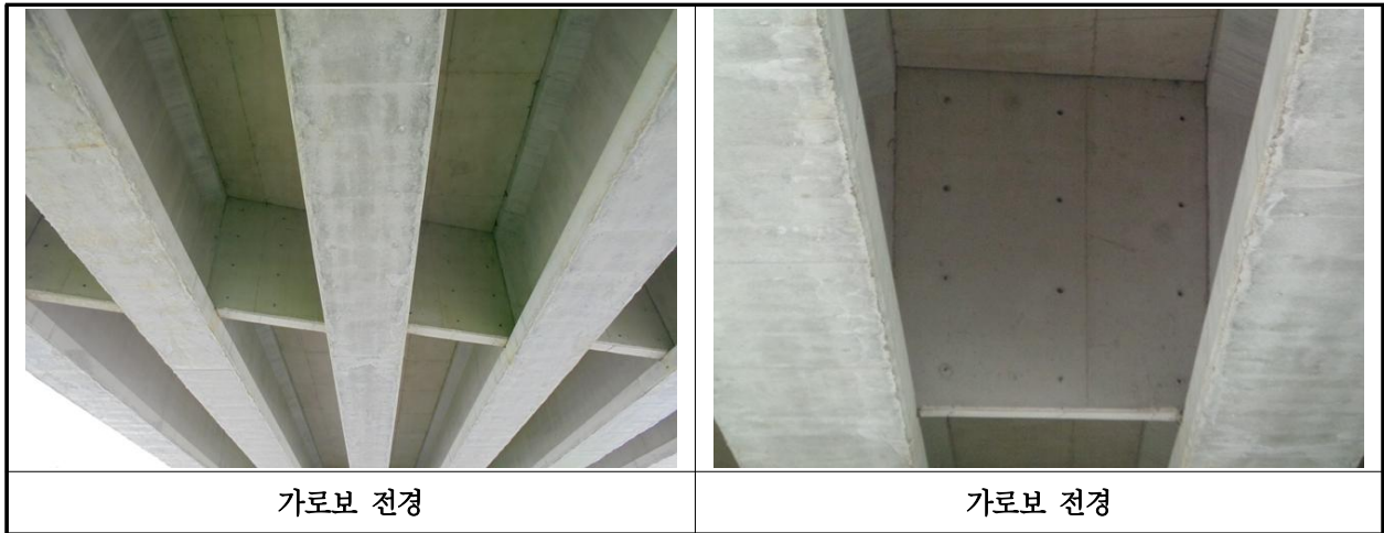
【사진 29.3.6】 가로보 전경
