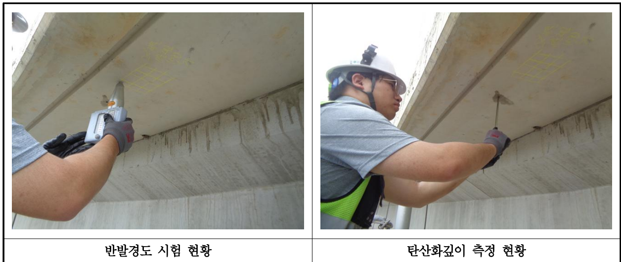
【사진 29.4.1】 콘크리트 내구성조사 현황
