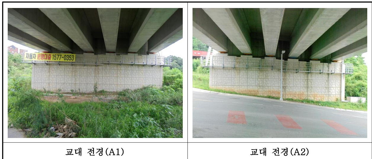
【사진 29.3.8】 교대 전경
