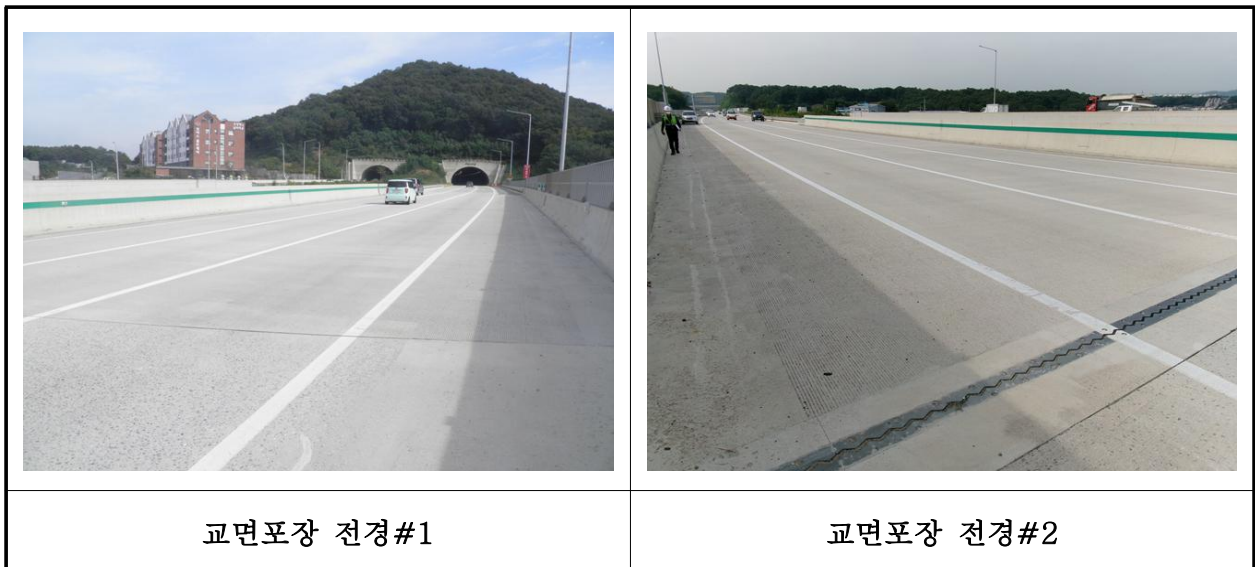
【사진 29.3.16】 교면포장 전경
