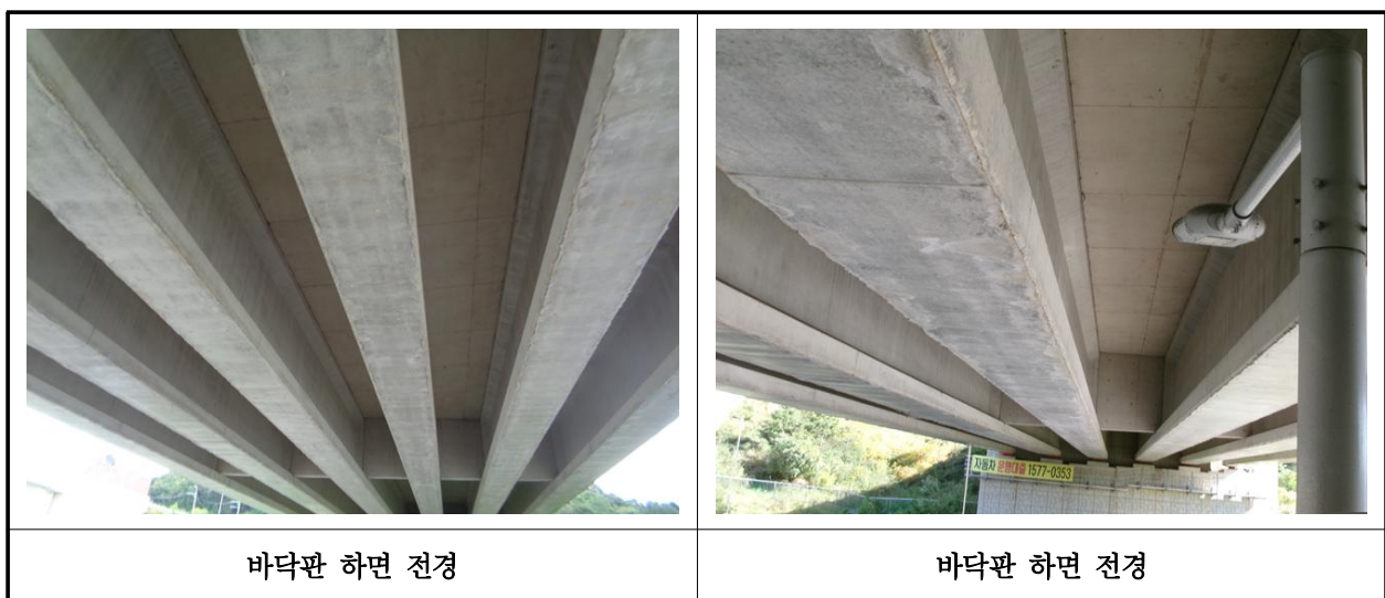
【사진 29.3.2】 바닥판하면 전경
