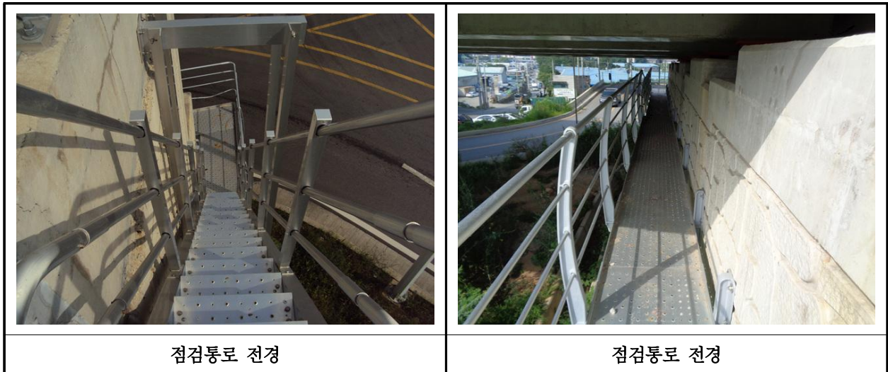
【사진 29.3.22】 교량 점검시설 전경
